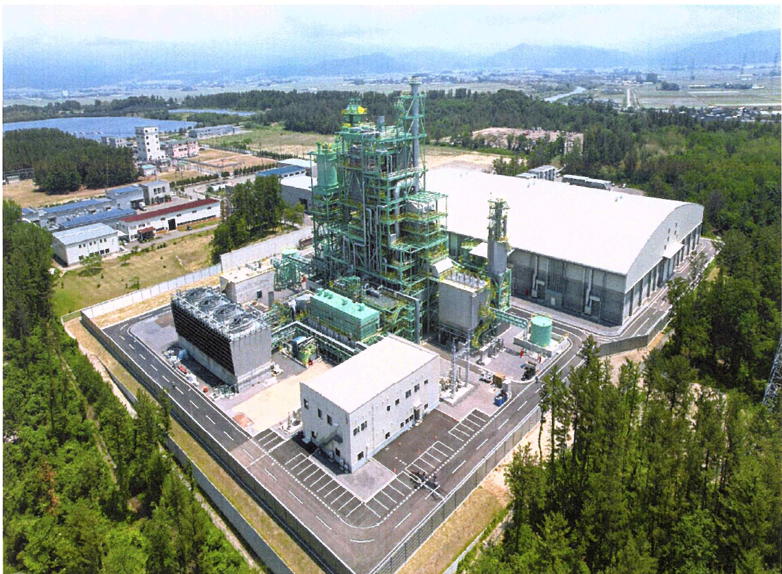
鳥海南バイオマスパワー株式会社「鳥海南バイオマス発電所」
